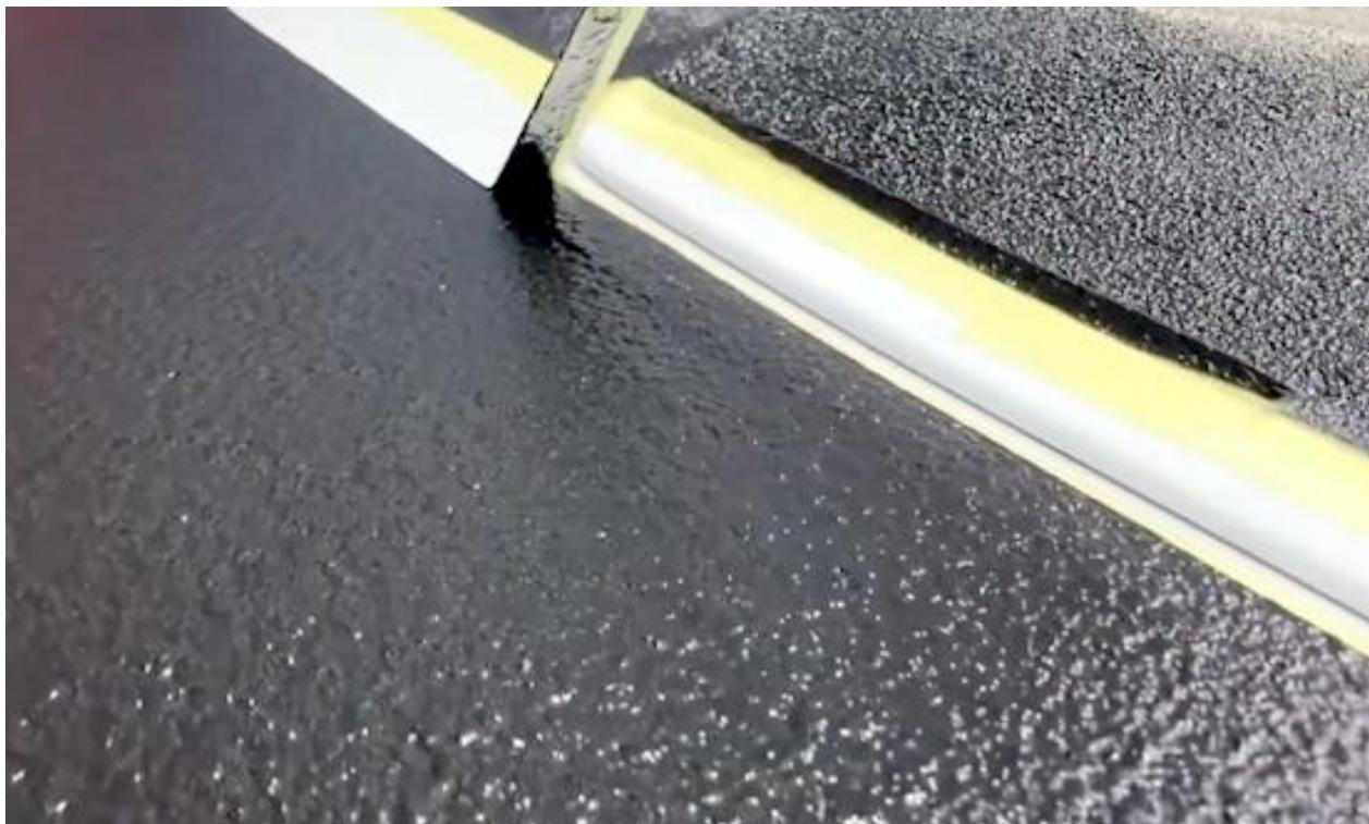
Bei Stellen, die du nur schwer erreicht, warte zirka 2 Stunden, bevor du das Klebeband entfernst.
