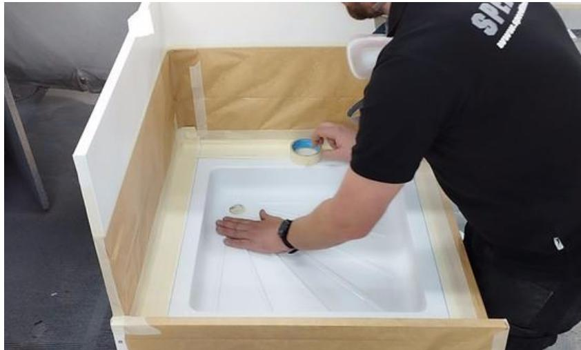
Um die Duschtasse klebt man zunächst ein Abdeckband mit zirka 20mm Abstand zum Rand der Duschwanne. Anschließend wird der Bereich zwischen Duschwanne und Klebeband mit einem 30mm Klebeband überklebt. Dieses Abklebeband wird als **Masterband** bezeichnet und nach dem Beschichten entfernt. Alle anderen Bereiche mit Abdeckpapier und Abdeckfolie vor Beschichtungsmaterial schützen. Nicht vergessen, den Abfluss zu verschließen/ abzukleben.
