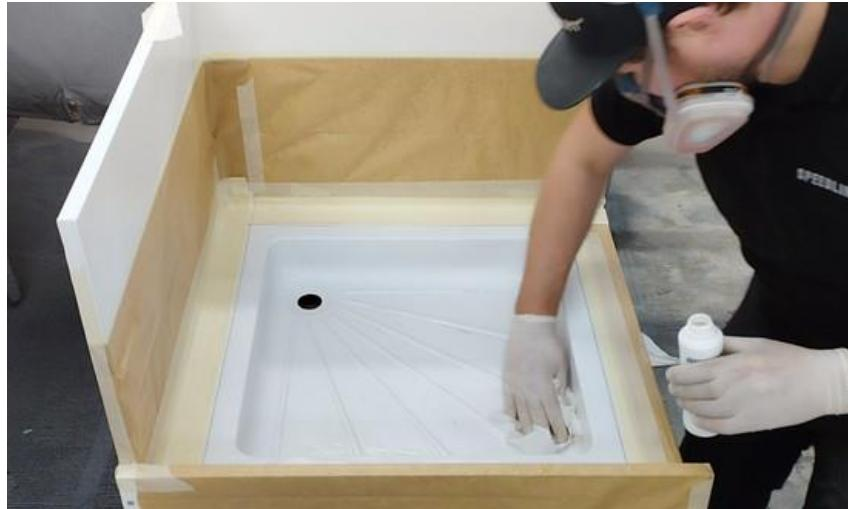
Trage mit dem Pinsel den PP100 – Plastik Primer auf alle zu beschichtenden PVC-Oberflächen in einer gleichmäßig dünnen Schicht auf – Boden, Seiten, Ränder.
