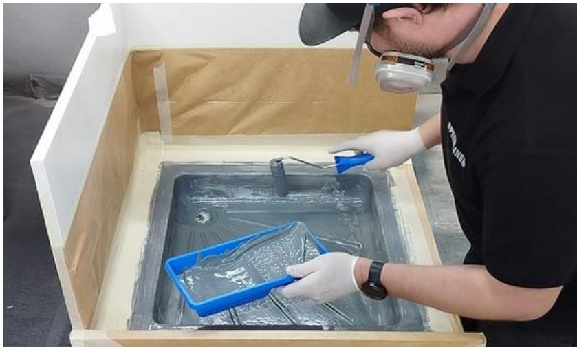
Anschließend wird mit der Rolle das restliche Material aufgetragen. Der Boden ist mit einer Schichtdicke von zirka 1 bis 1.5 mm zu rollen. Die Seitenwände mit einer Schichtdicke von zirka 1 mm. Größere Schichtdicken sind jederzeit möglich. Je nach Wunsch ist es möglich mehrere Schichten nacheinander aufzutragen.
