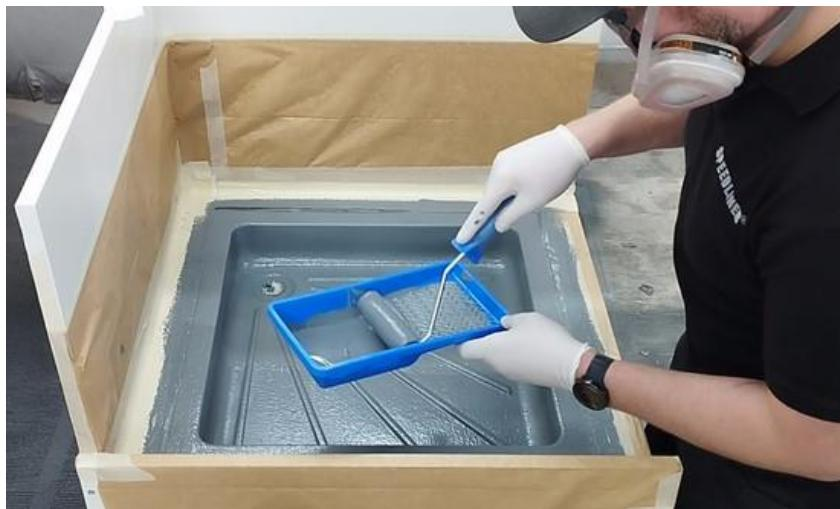
Je nach eingesetzter Farbwalze sind unterschiedliche Texturen möglich. Mit unserer Standard Farbwalze erzielst du eine leicht strukturierte und mit der Strukturwalze eine deutlich stärker strukturierte Oberfläche.
